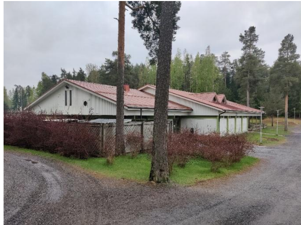
Nykyinen purettava huoltorakennus
