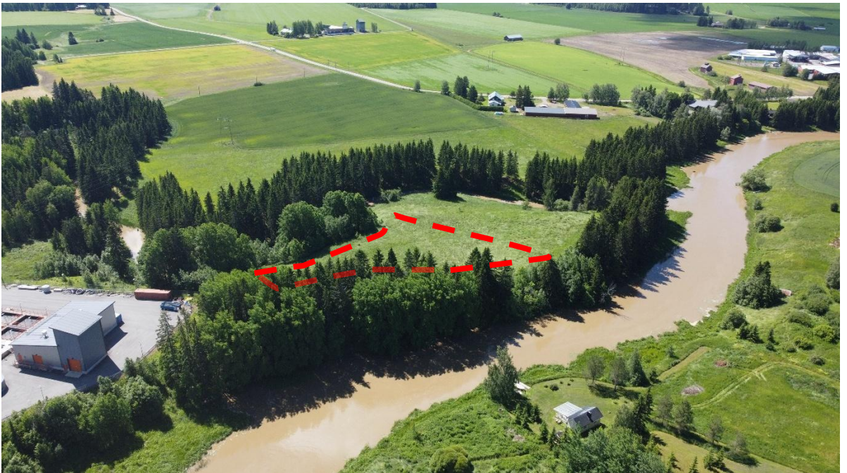
Kuva 6 – Viistonäkymä lounaan suuntaan.
