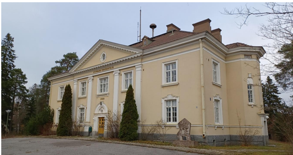
Kuva 8 – Hirvikosken entinen kunnantalo on ennestään asemakaavalla suojeltu ja maakunnallisesti arvokkaaksi luokiteltu kohde. Kohteesta on laadittu erillinen rakennushistoriallinen selvitys asemakaavaprosessin aikana.
