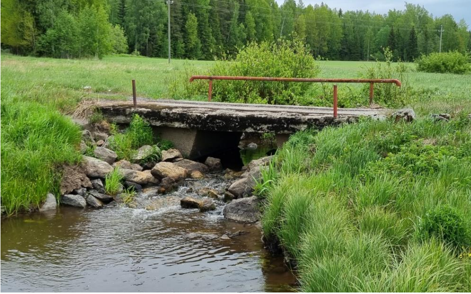
Kuva 7.1. Uusittava siltarakenne PI 5170
