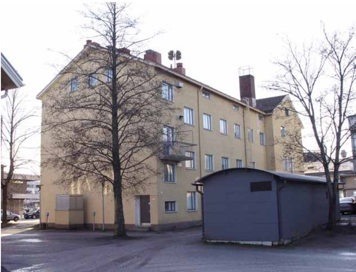
kuva 17 Varsinkin Satakunnantien suuntaan kaupungintalon ilmeissä on nähtävissä asuinkerrostalonkin piirteitä. Nykyisen ikkunajaotuksen pohjana ovat olleet toisessa kerroksessa sijainneet asunnot.
