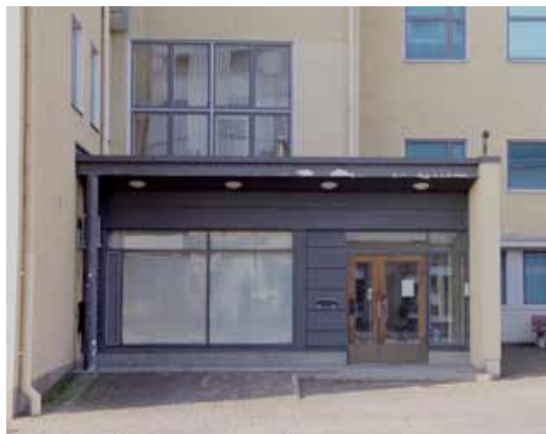
kuva 8 Nykyisessä pääsisäänkäynnissä on sekä moderneja aiheita että rapattua seinäpintaa.
