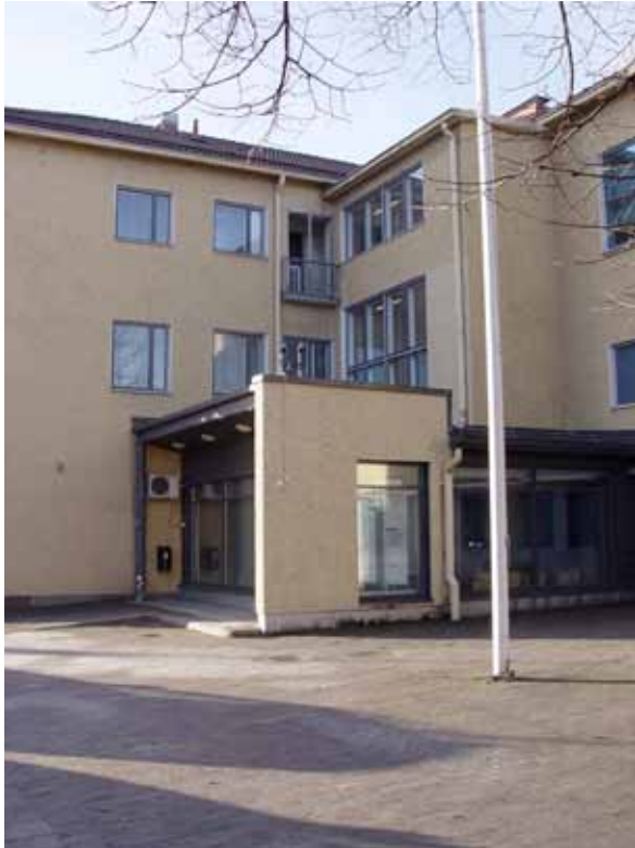
kuva 12 Pääsisäänkäynti ja lasi-ikkunainen porrashuone sen takana
