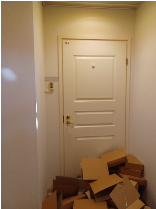
Kuva 53 Väliovet ovat enimmäkseen tehdasvalmisteisia, puristelevystä valmistettuja valsepeiliovia. Alkuperäisiä väliovia on jäljellä vain pari, ja niiden lukot ja kädensijat on vaihdettu uudenaikaisiin. Kuvassa vasemman puoleinen ovi on uusi, ja oikean puoleinen on uudistettu, mutta alkuperäinen.
