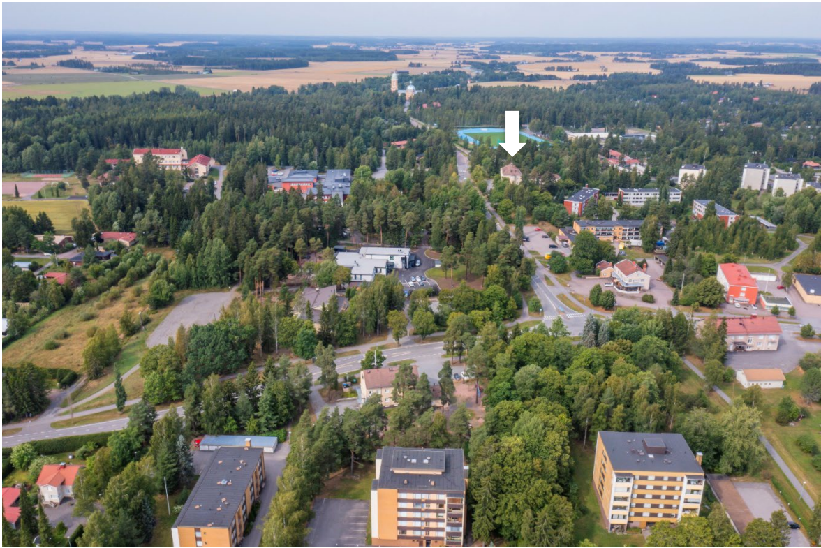
Kuva 2 Viistoilmakuva (dronekuva) Hirvikosken kylästä suurin piirtein etelästä pohjoisen suuntaan. Kunnantalon vanha osa näkyy valkoisen nuolen osoittamassa kohdassa.
