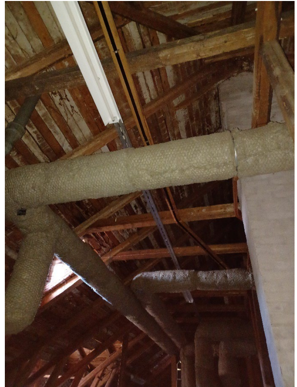
Kuva 64 Ullakko on eristämätöntä, avointa tilaa, jossa vanhat kattorakenteet ja uudemman aikaiset ilmanvaihtoputkistot ovat vapaasti näkyvissä.
