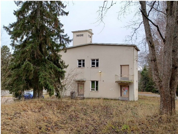
Kuva 18 Entinen paloasema kuvattuna kunnantalon paikoitusalueelta.
