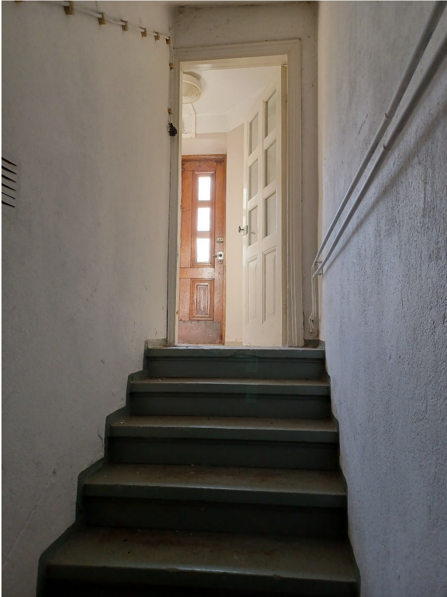
Kuva 55 Kellariin johtava portaikko on alkuperäisessä asussaan. Betoniportaajat ja seinät on uudelleenmaalattu.
