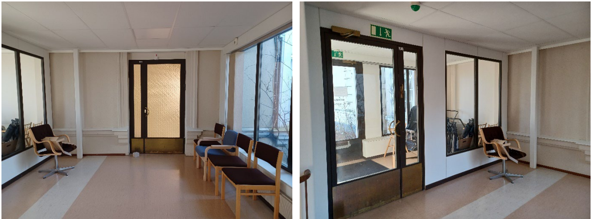
Kuva 87 Yksi vanhan osan ikkunoista on laajennettu sisäänkäynniksi yhdysosaan. Oikeanpuoleisessa kuvassa on yhdysosan tuulikaappi ja sisäänkäynti.
