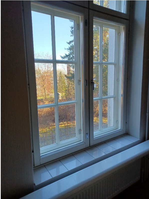
Kuva 49 Sisäikkunat ovat yksilasiset puu-alumiini-ikkunat.
