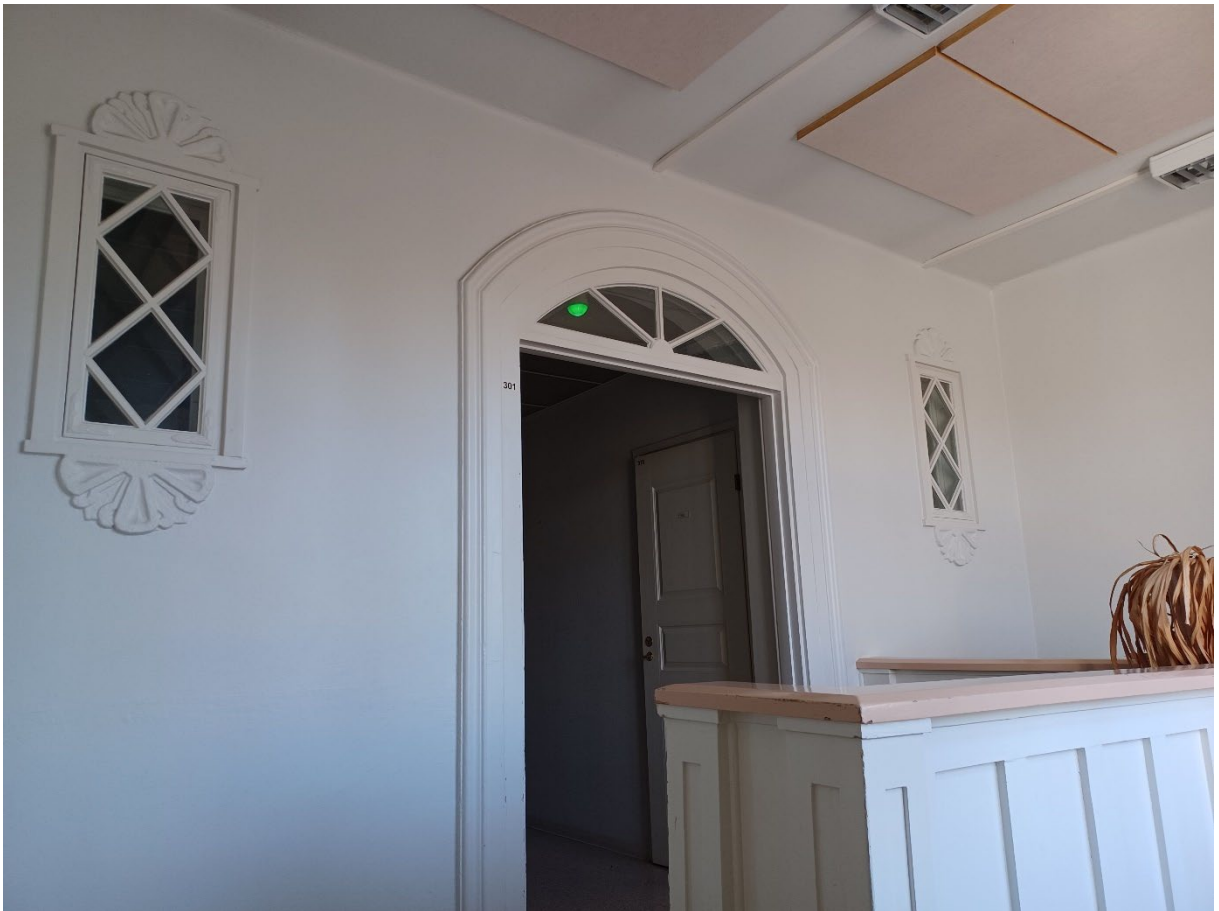
Kuva 62 Ylhäällä vasemmalla toisen kerroksen wc-tila, joka on rakennettu peruskorjauksen yhteydessä. Oikealla ja alhaalla alkuperäistä portaikkoa uusklassistisine muoto- ja koristeaiheineen. Toinen koristeikkunoista on jäänyt wc-tilan puolelle.
