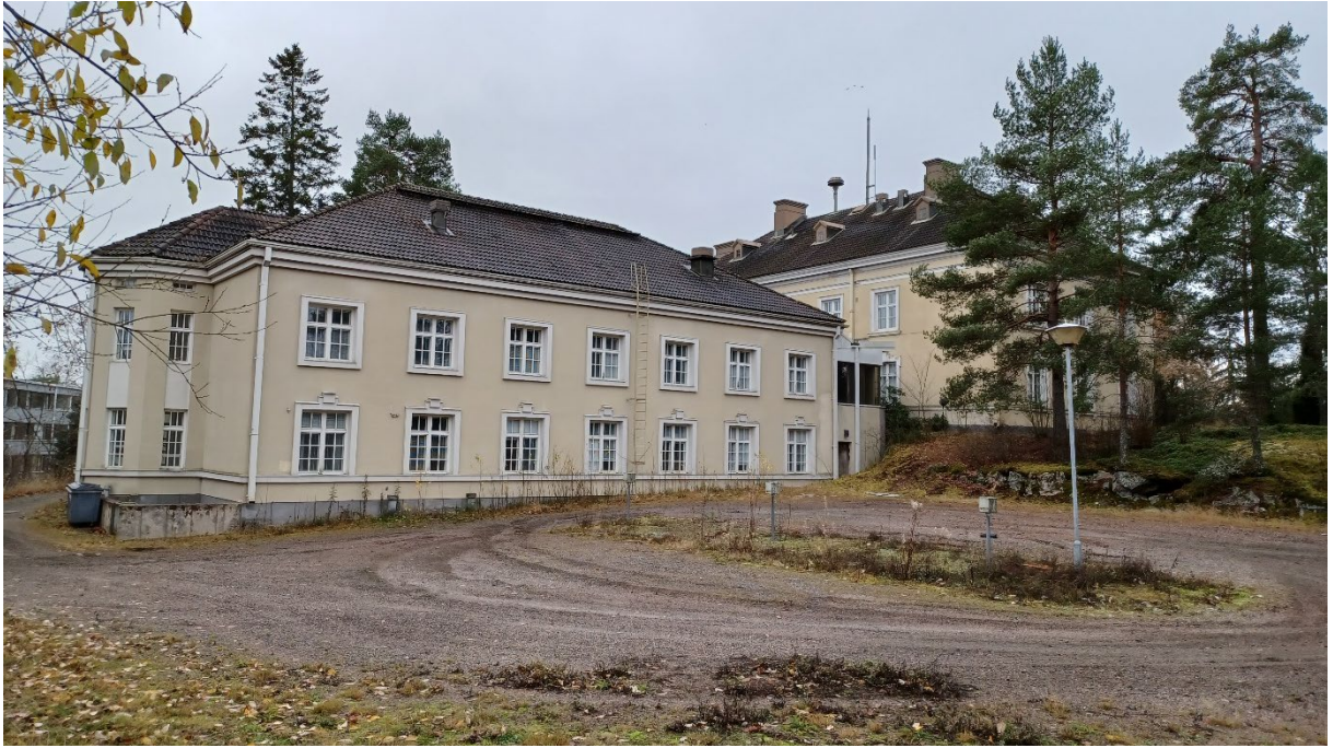
Kuva 79 Julkisivu pohjoiseen ja paikoitusalue.
