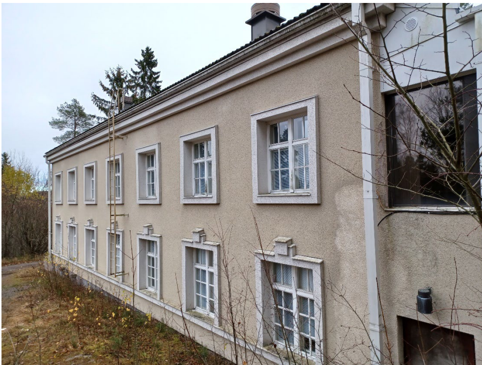
Kuva 84 Rakennuksen ulkoikkunat ovat moniruutuiset ja parikymmentä senttiä seinäpinnan sisäpuolella johtuen seinärakenteesta. Lämmöneriste on ulkoseinän puolella.
