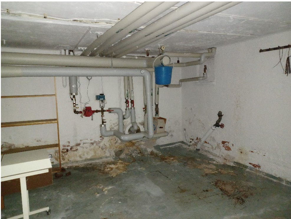
Kuva 57 Entinen pannuhuone. Rakennuksen vesiputket on uusittu.
