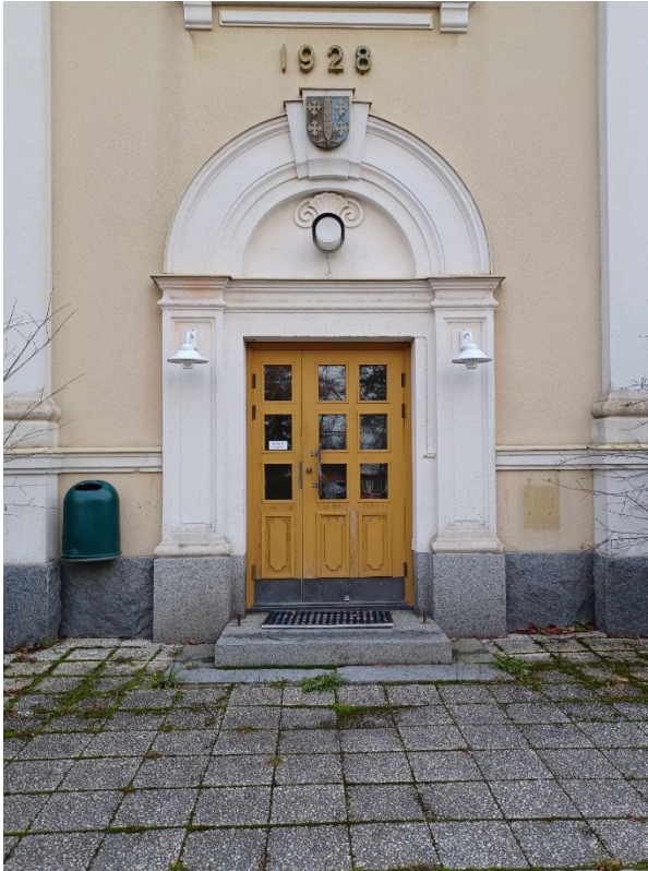
Kuva 40 Vasemmanpuoleisessa kuvassa näkyvä pääsisäänkäynti on kehystetty kaaren muotoisella koristeaiheella (arkkitraavi), jonka yläosassa on yksinkertainen valaisin sekä vaakuna. Sivuilla olevat valaisimet eivät ole alkuperäiset, vaan ne on lisätty myöhemmin. Sivuportaikon sisäänkäynti (oikealla) on pelkistetympi. Molempien sisäänkäyntien tammiovet lienevät alkuperäiset, mutta ainakin pääsisäänkäynnin ovea on korjattu ja maalattu.
