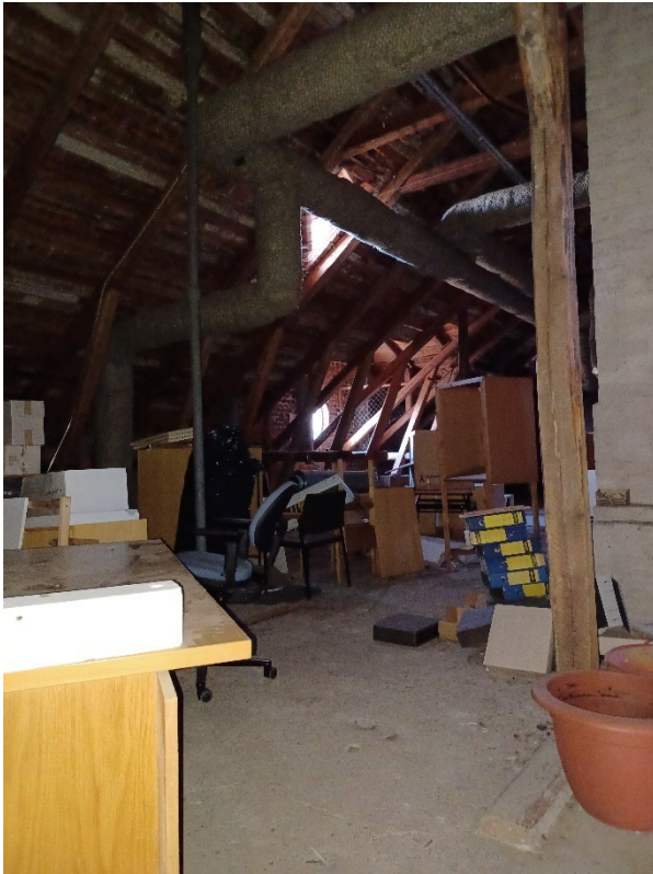
Kuva 64 Ullakko on eristämätöntä, avointa tilaa, jossa vanhat kattorakenteet ja uudemman aikaiset ilmanvaihtoputkistot ovat vapaasti näkyvissä.
