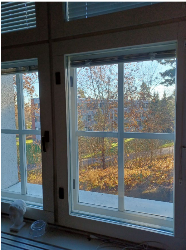
Kuva 91 Sisäikkunat ovat yksiruutuiset ja puu-alumiinirakenteiset.
