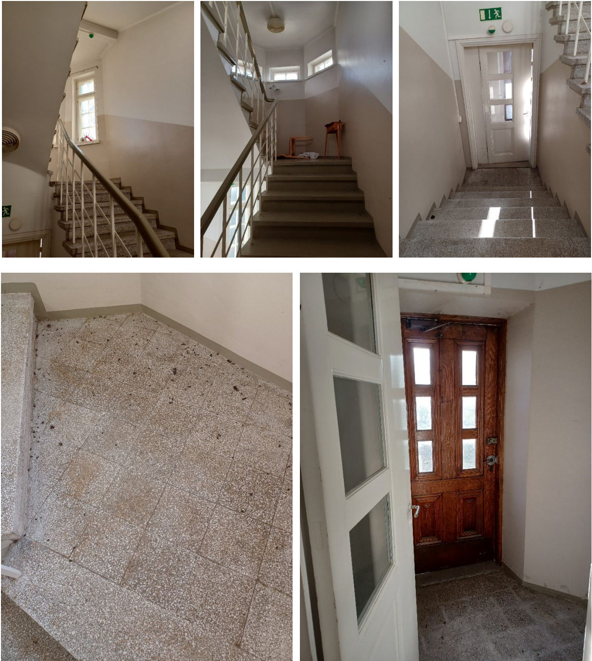
Kuva 54 Torniosan portaikossa on paljon alkuperäistä jäljellä. Ovet ovat alkuperäiset, samoin pintamateriaalit (uusittua maalipintaa lukuun ottamatta) kuten mosaiikkibetoniportaat ja porraskaiteet.
