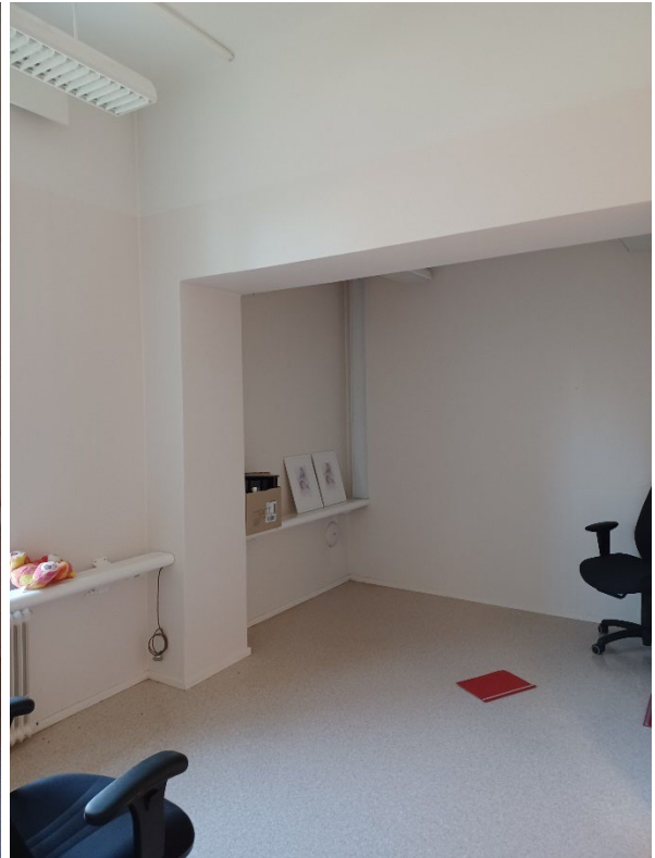
Kuva 45 Toimistohuoneet ovat hyvin saman näköisiä keskenään. Lattioita peittää vaalea muovimatto, ja seinissä on valkoiseksi maalattu lasikuitutapetti tai kangastapetti. Valurautainen lämpöpatteri on iäkäs (arviolta 1940-luvulta tai vanhempi).
