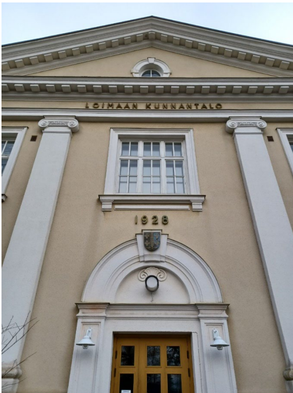
Kuva 41 Sisäänkäynti on kehystetty kaaren muotoisella koristeaiheella, jonka yläosassa on yksinkertainen valaisin sekä vaakuna. Sivuilla olevat valaisimet eivät ole alkuperäiset, vaan ne on lisätty myöhemmin.
