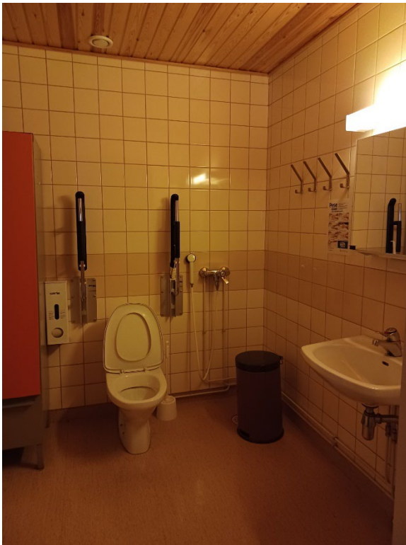
Kuva 97 Wc-tiloissa on niin ikään muovimatot, ja seinät on kaa- keloitu. Pinnat ovat alkuperäiset.
