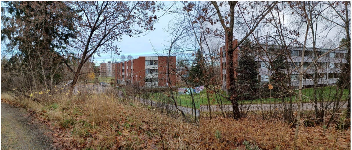
Kuva 19 Kolme asuin kerrostaloa kunnantalon kaakkoispuolella kuvattuna kunnantalon paikoitusalueelle johtavalta pihatieltä.
