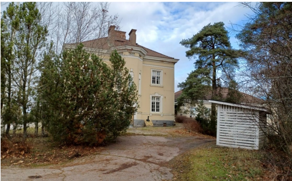
Kuva 36 Rakennuksen ympärillä on laatoitusta ja vanhoja mäntyjä. Ulompi piha-alue ja koko etupiha on asfaltoitu. Kuvassa näkyy myös pyöräkatos, joka lienee rakennettu 2000-luvulla. Kuvan suunta etelästä pohjoiseen päin.
