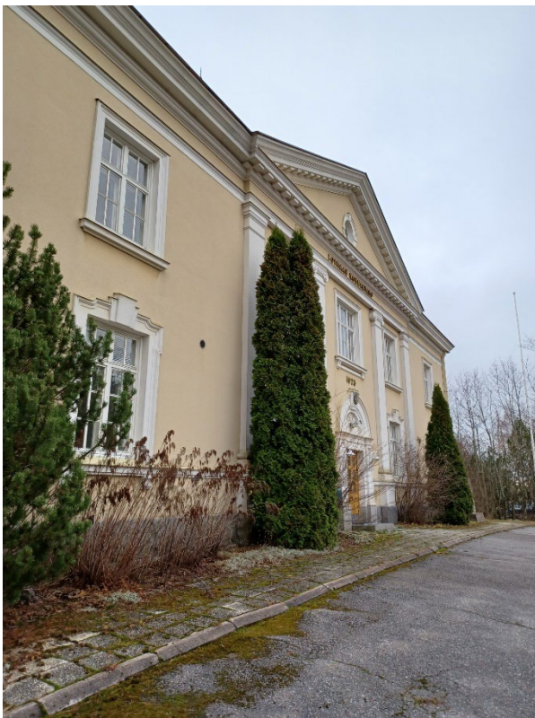
Kuva 39 Rakennuksen pääjulkisivua lännen puolella.
