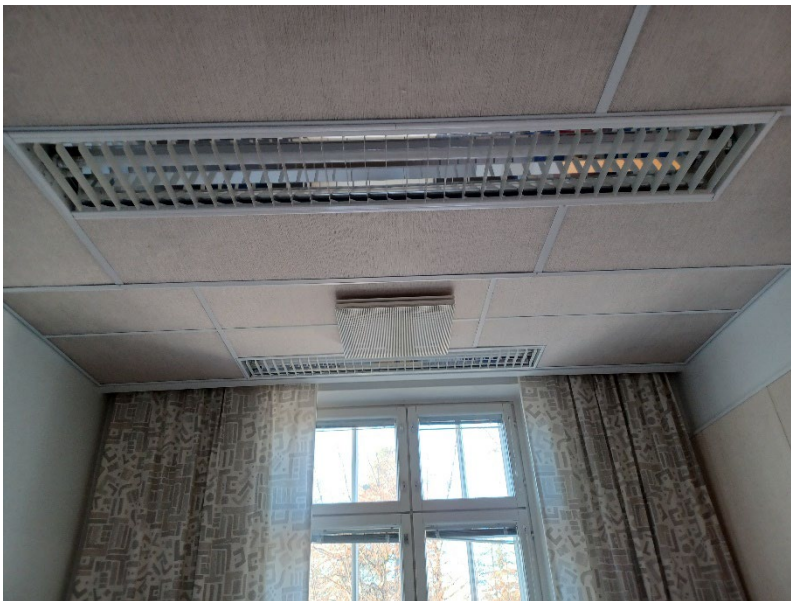
Kuva 50 Alaslasketut sisäkatot on pinnoitettu akustiikkalevyin. Loisteputkivalaisimet on upotettu kattoon.
