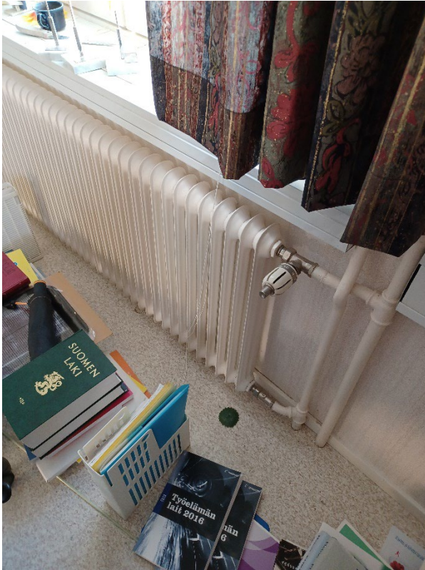
Kuva 52 Osaan huoneista on jätetty vanhat valurautapatterit.
