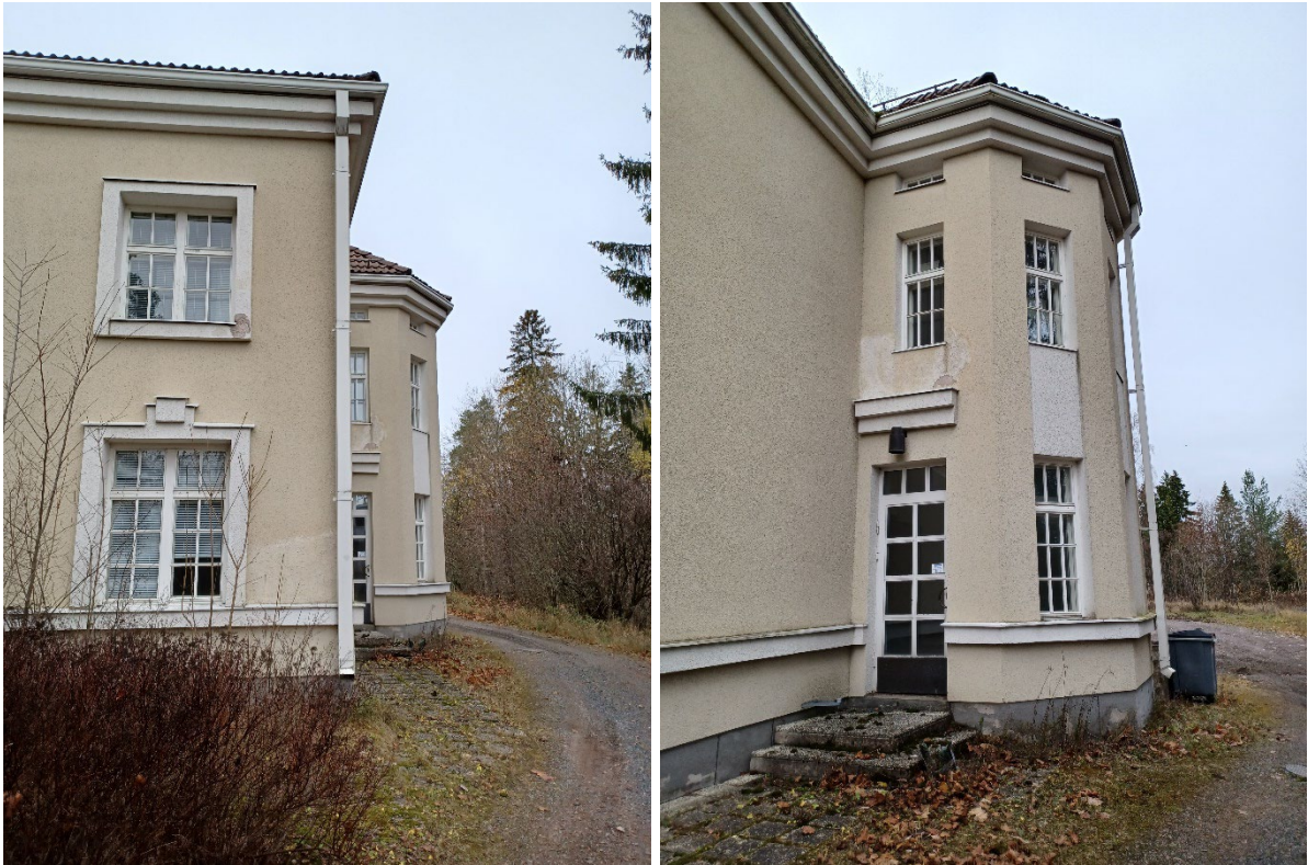
Kuva 83 Rakennuksen päädyssä on samankaltainen, monikulmainen tornimainen pääty, kuin on vanhassa osassa.
